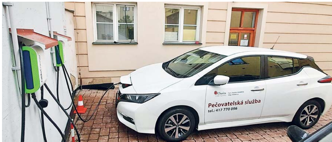
Pro elektromobily si v litoměřické Charitě vybudovali i vlastní dobíjecí stanice.
